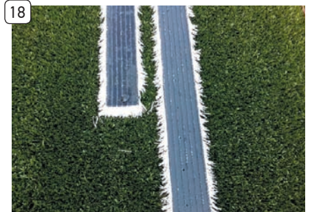
Otočení a napnutí lajn - relaxace
