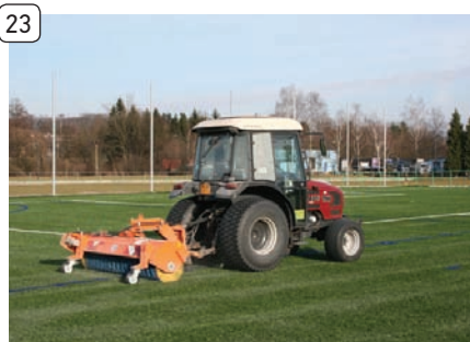
Kartáčování po zapravení zásypu - písek
