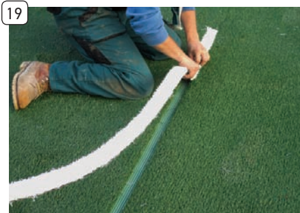
Vložení lajny do lepidla
