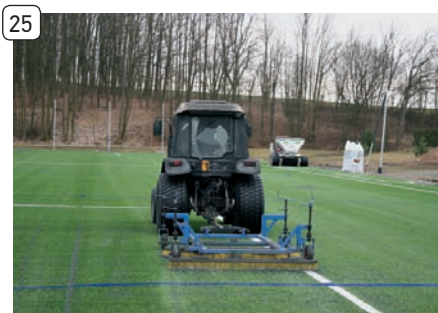
Kartáčování po zapravení zásypu - granulát
