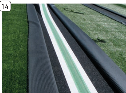
Vložení podlepovací pásky s lepidlem
