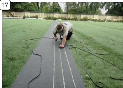
Rozřezání lajn, odříznutí části mezi stehy
