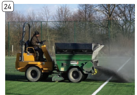
Vpravení zásypu do UT - granulát
